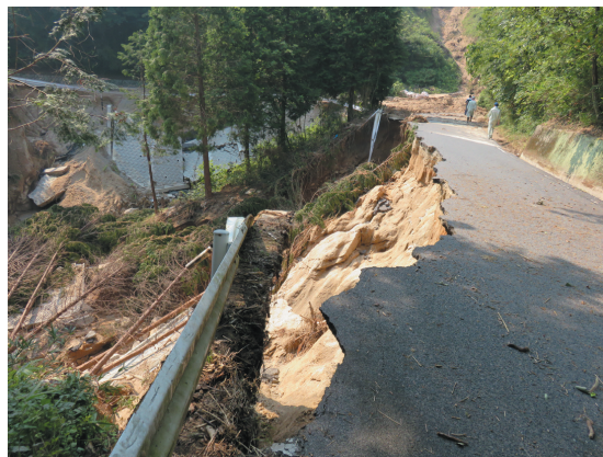
▲平成30年7月豪雨災害では市内の至る所で土砂崩れなどの被害がありました。
